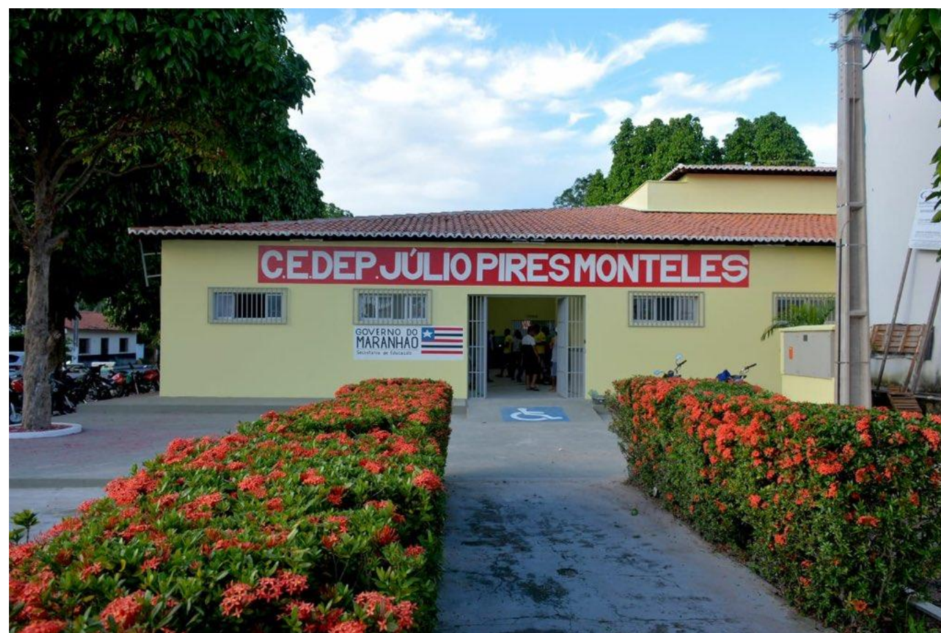
Reforma do CE Dep. Júlio Pires Monteles em Anapurus
