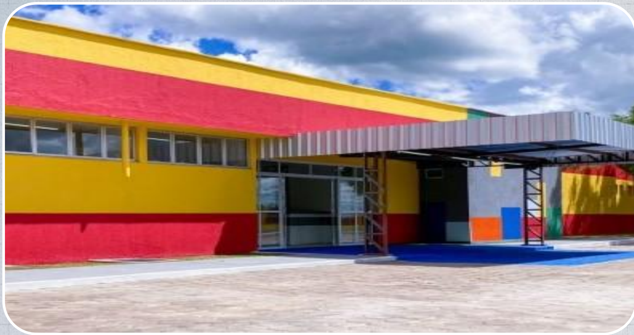
Hospital de Buritirana – obra em andamento
