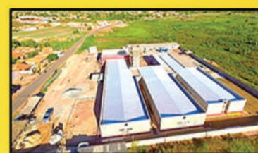
Hospital Regional do Lago da Pedra Território Médio Mearim
