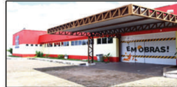
Hospital de Matões do Norte (obra em andamento) Território Vale do Itapecuru
