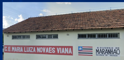
Construção da CE Maria Luiza Novaes Viana
