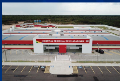
Construção do Hospital Regional
