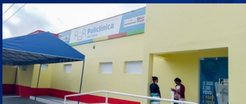
Construção da Policlínica de São Bento
