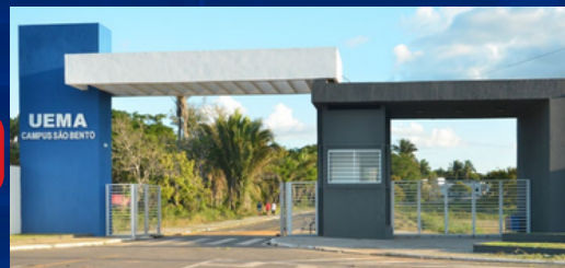
Construção de Polo da UEMA em São Bento
