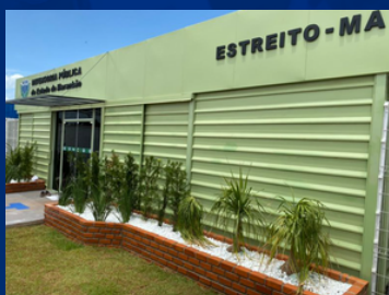
Construção de núcleo regional da DPE em Estreito
