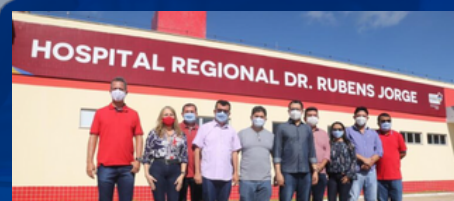
Construção do Hospital Regional Dr. Rubens Jorge
