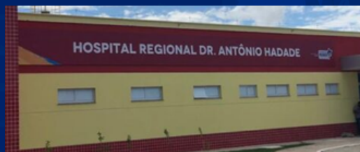
Construção de Hospital de Alta Complexidade
