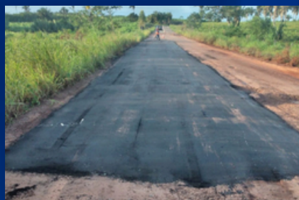
Pavimentação de Vias Urbanas
