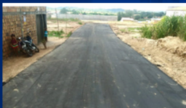
Pavimentação de Vias Urbanas
