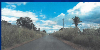
Pavimentação de Vias Urbanas
