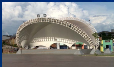
Requalificação da Avenida Beira-mar e Revitalização Concha Acústica
